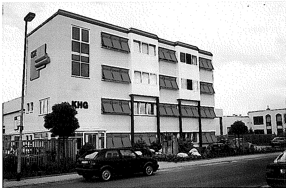
Das neue Verwaltungs- gebäude der KHG in Karben
